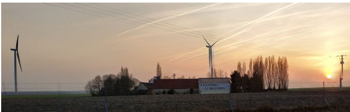
Une partie du site éolien près de l'aire de Marmagne située sur l'A 71 avec cette grande affiche sur le bâtiment situé en premier plan. Photo. JMT février 2019.
